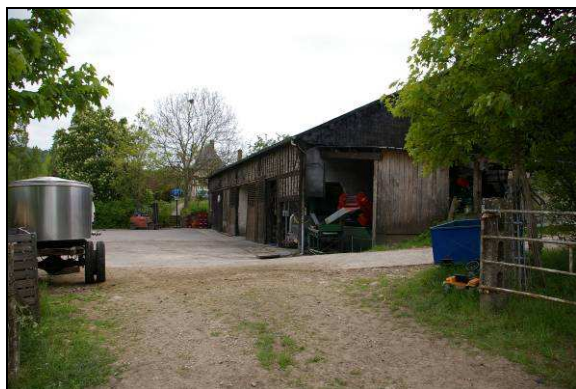
Bâtiments de transformation
